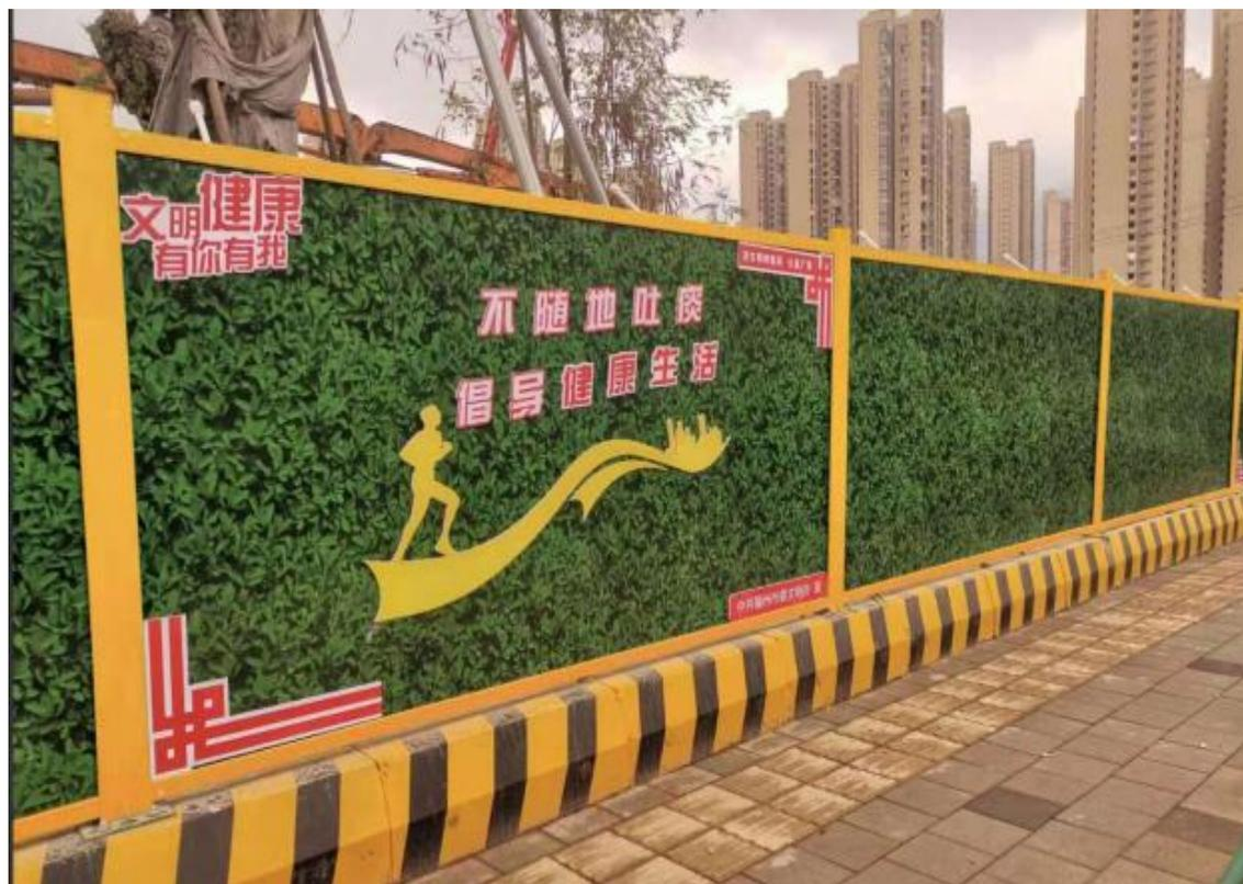
3.3.2 围挡由预制钢筋混凝土基座、工形方钢立柱、凹型方钢管压顶及地梁、钢木复合面板、警示灯及喷淋系统组成，设置斜撑一道。
