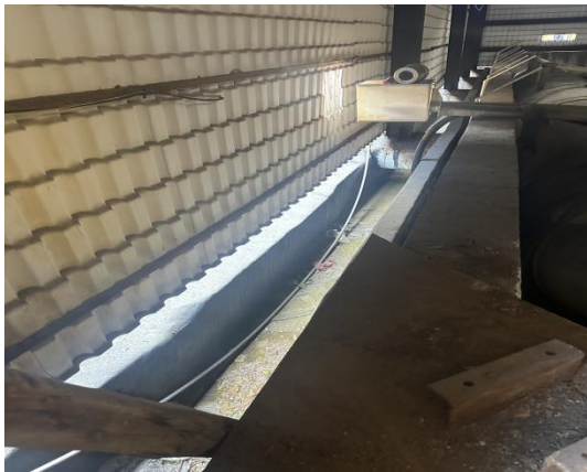
氢氟酸罐区围堰
