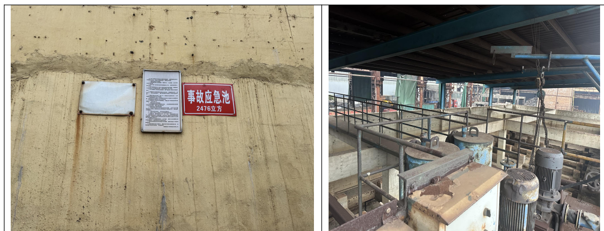
图 8.7-1 厂区现有 2476m 3 事故应急池照片
